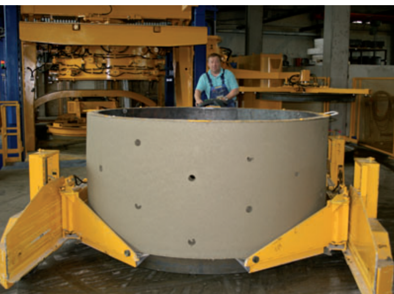
Il trasporto dei prodotti fuori dall'impianto viene effettuato con appositi carrelli elettrici.
