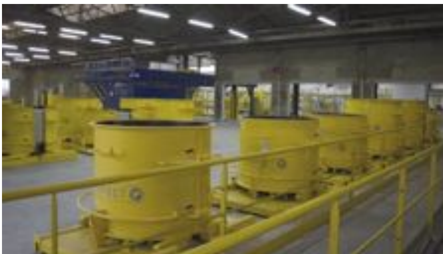
Świeżo napełnione betonem formy przewożone są specjalnym wózkiem akumulatorowym na miejsce dojrzewania.
