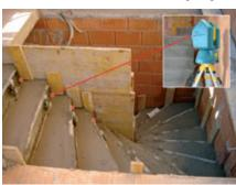
ProCollector und die drahtlose Bedienungseinheit ProCommander werden auf Baustellen als zeitsparendes Aufmasssystem für den Treppenbau, Verschalungen und den Innenausbau eingesetzt.
