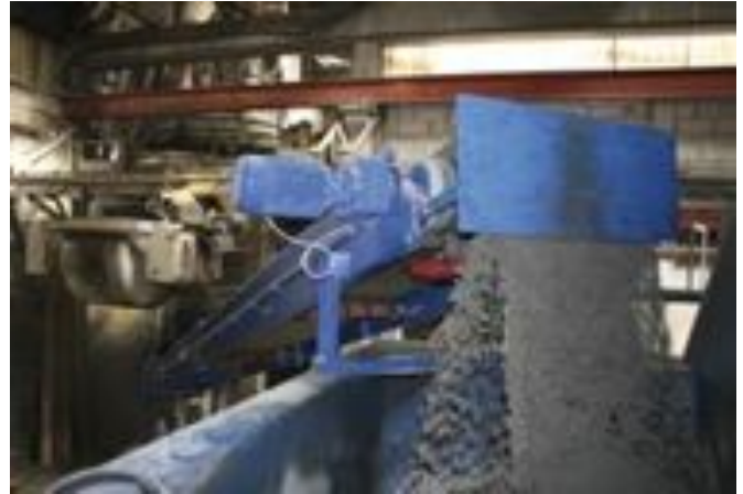
Dostawa betonu do MAGIC 1501 realizowana jest przez istniejące już w firmie Frühwald węzły betoniarskie.
