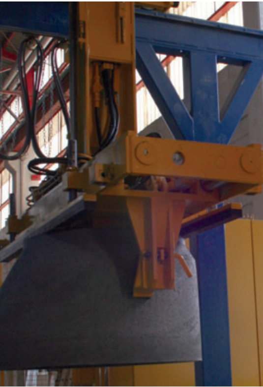
La gru sposta l'elemento per pozzetto tramite benne
