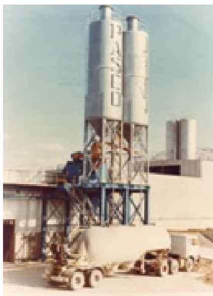
Pierwsza linia technologiczna Pasco wraz z węzłem betoniarskim.
