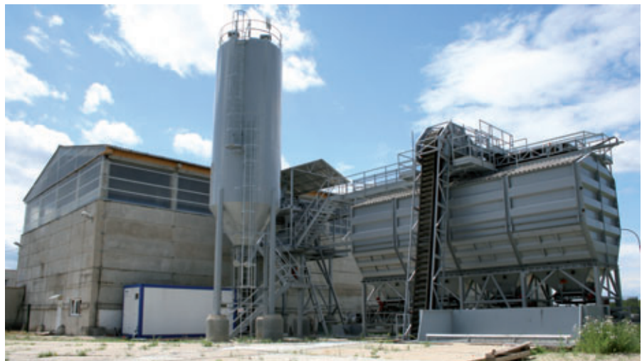
Zábójník s.r.o.'s new factory in Slovakia
