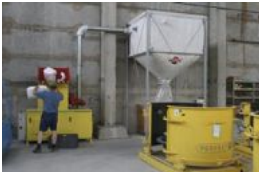
Usunięte kształtki styropianowe zostają rozdrobnione za pomocą szatkownicy firmy Heger GmbH.
