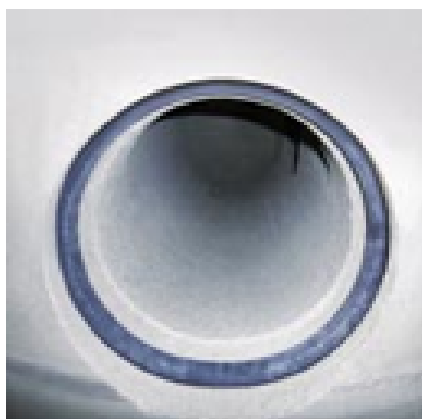
Wszystkie uszczelki dla przyłączy są przyklejane klejem polimerowym w przeznaczonych na nie rowkach.
