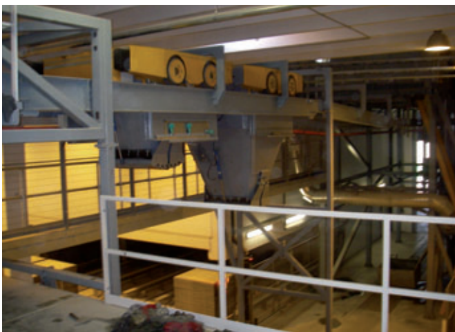
Trasporto del calcestruzzo con Conflex della Skako (vagonetti da 0,75 m 2 e 2 m 2 )
