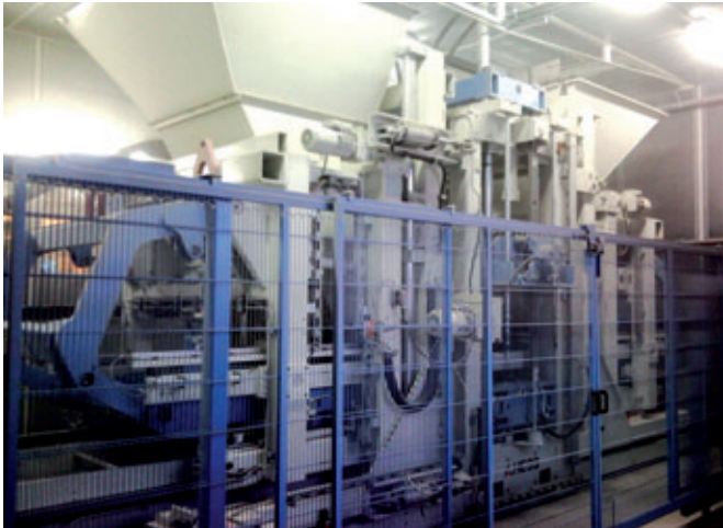
La Hess RH 1500-2 nella copertura della Kaschwig
