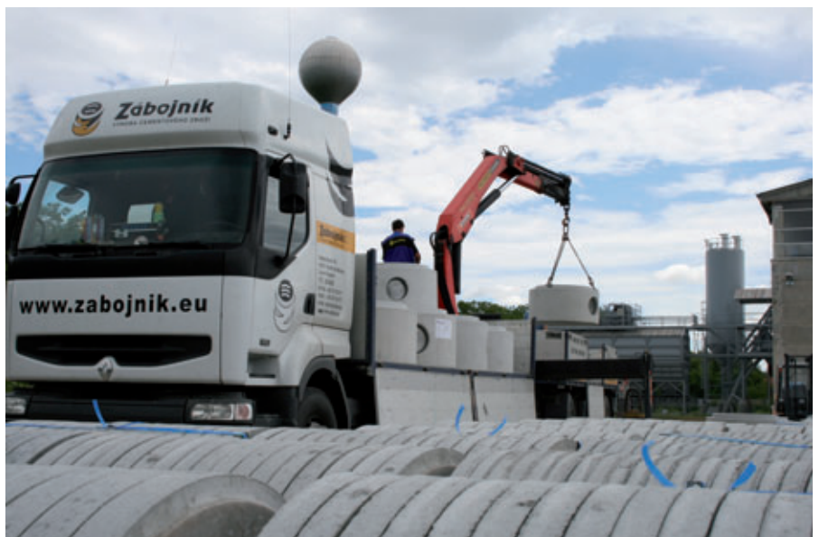
Nel nuovo stabilimento si fabbricano gli elementi di fondo per pozzetto, il resto dei prodotti invece nello stabilimento centrale ceco per poi essere consegnati in Slovacchia
