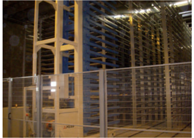
Hess-Fahrzeuggruppe vor dem Rhotho-Regalsystem mit einer Kapazität von 5.700 Fertigungsbrettern
