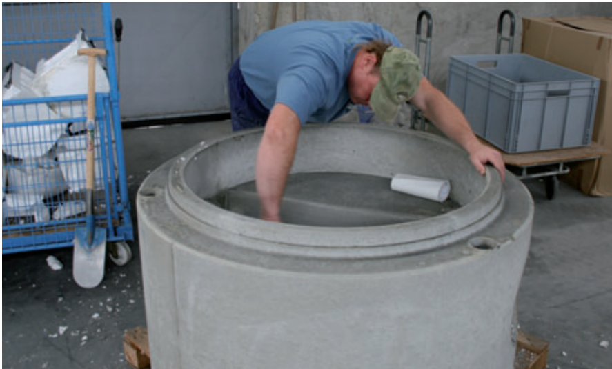
Entfernung der Aussparungskörper
