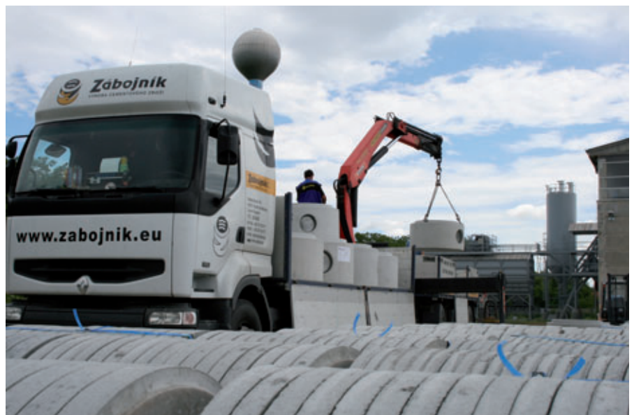
In dem neuen Werk werden nur Schachtunterteile hergestellt, das sonstige Schachtprogramm wird im tschechischen Hauptwerk produziert und in die Slowakei geliefert
