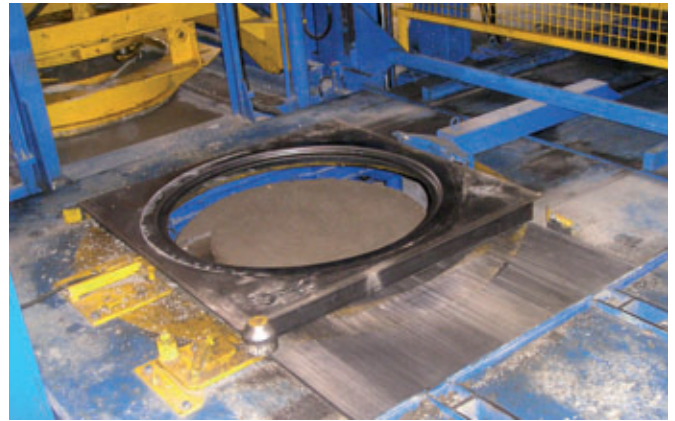
Déroulement d'un cycle de production : insertion de l'embase, remplissage béton, le cône du regard de visite est démoulé suite au compactage avant d'être retiré de l'installation
