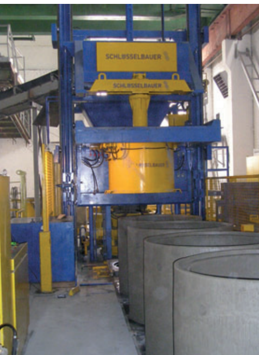
Les produits frais demeurent sur une « aire de stationnement » avant d'être transportés dans l'espace de séchage
