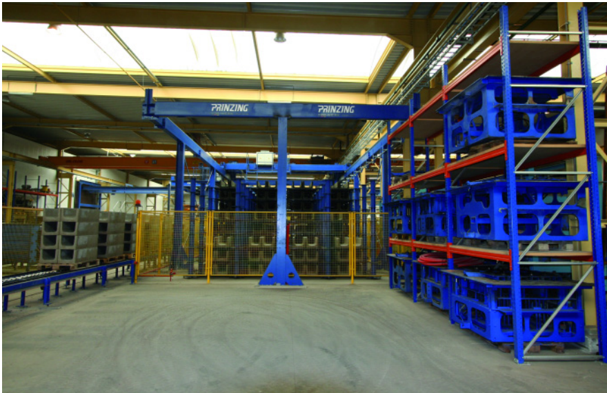
В г. Розелар в процессе проектирования установки была учтена возможность расширения стеллажей для твердения, что дает возможность работать в две смены
