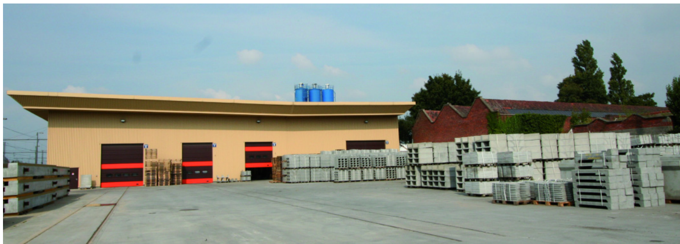
Современно оборудованный завод по производству железобетонных конструкций компании Infrabel в городе Розелар
