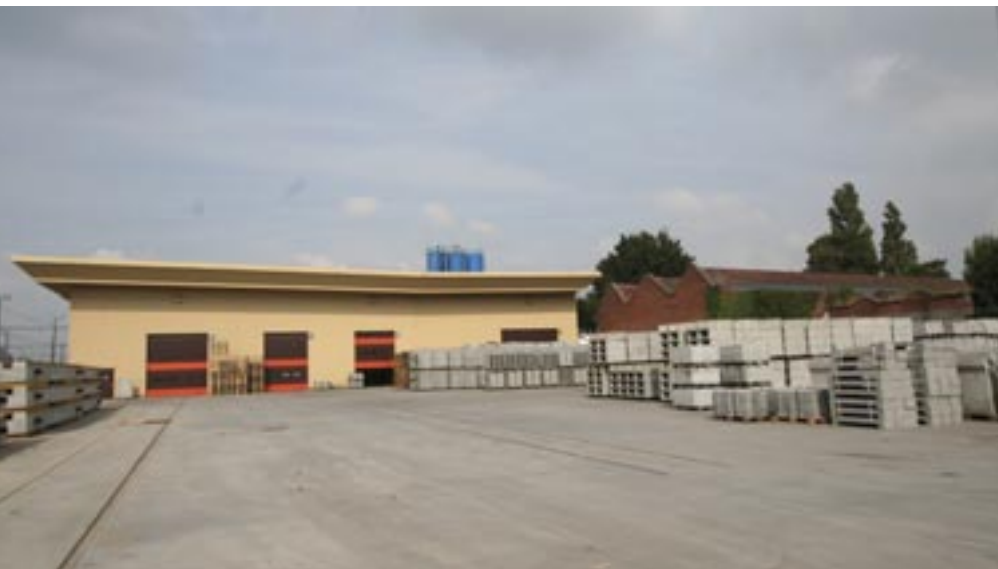
Nowocześnie wyposażony zakład betonowy Infrabel w Roeselare.
