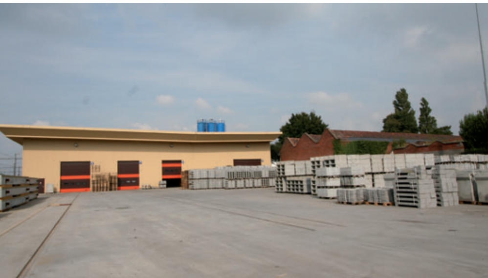
Lo stabilimento di prefabbricazione di Infrabel a Roeselare, dotato di attrezzature moderne
