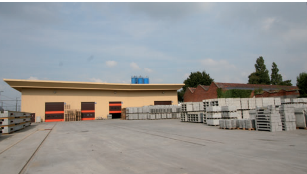
Le site moderne de production de béton Infrabel à Roeselare
