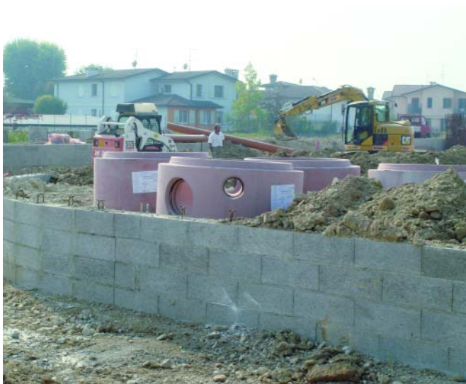
Установка кольца с днищем фирмы Buzzella Ennio S.r.l. из высокопрочного бетона.
