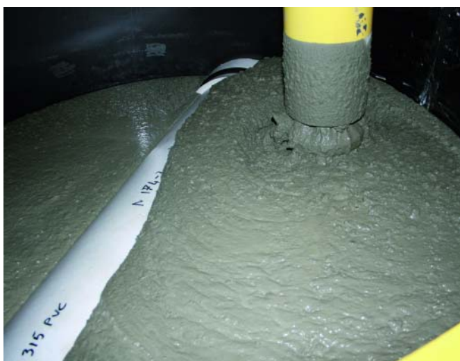
Заливка формы самоуплотняющимся бетоном C40/50.
