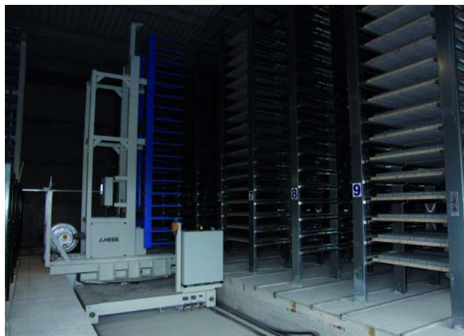
Рис.3. Транспортировка изделий в камеры выдержки Rotho
