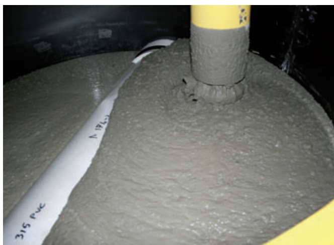
Riempimento dello stampo in acciaio con calcestruzzo autoindurente, C40/50
