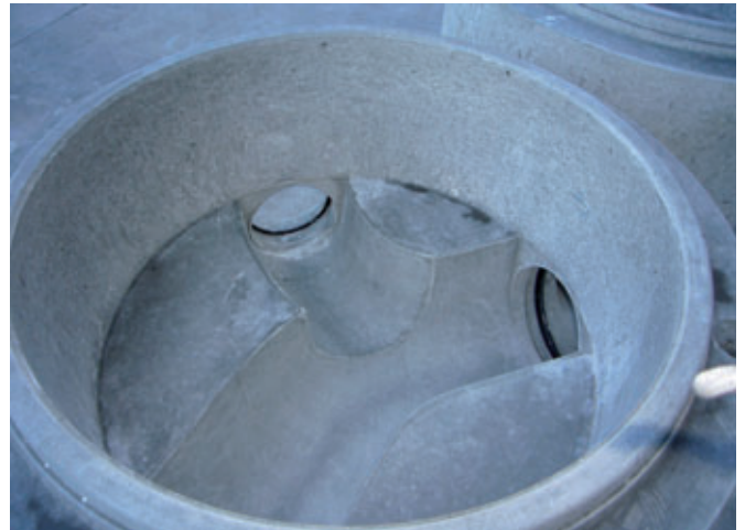
Canali di scolo ideali sotto il profilo idraulico, impiego di guarnizioni integrate per collegamento semplice e sicuro alle tubature
