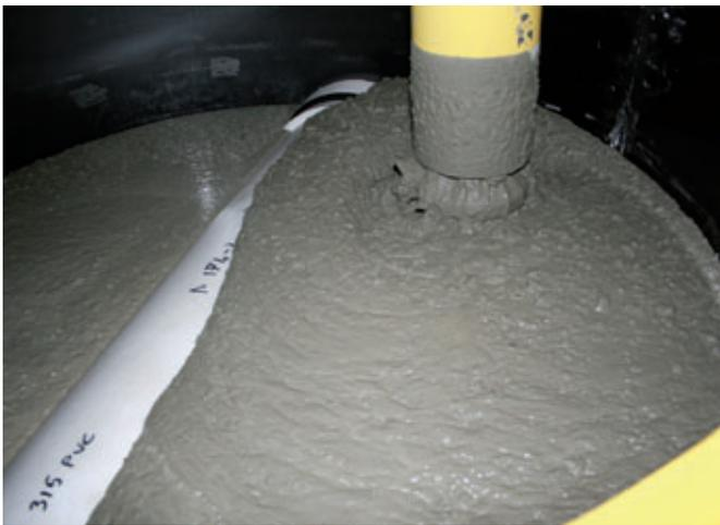
Remplissage du moule en acier avec du béton autoplaçant de classe C40/50
