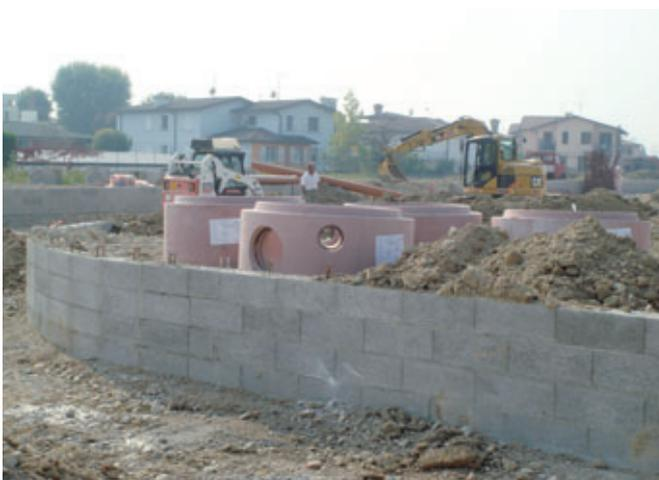
Einsatz von Hochleistungsbeton-Schachtunterteilen von Buzzella Ennio SRL
