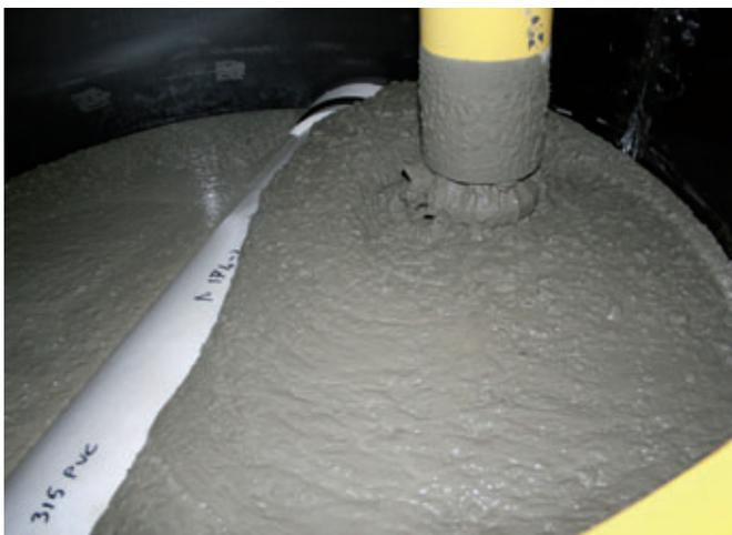
Befüllen der Stahlform mit selbstverdichtendem Beton, C40/50
