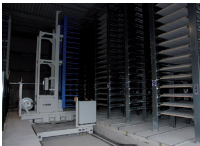
Abb. 3: Die Fahrzeuggruppe bringt die Fertigungsunterlagen in das der Anlage gegenüber aufgebaute Aushärteregeal der Fa. Rotho.
