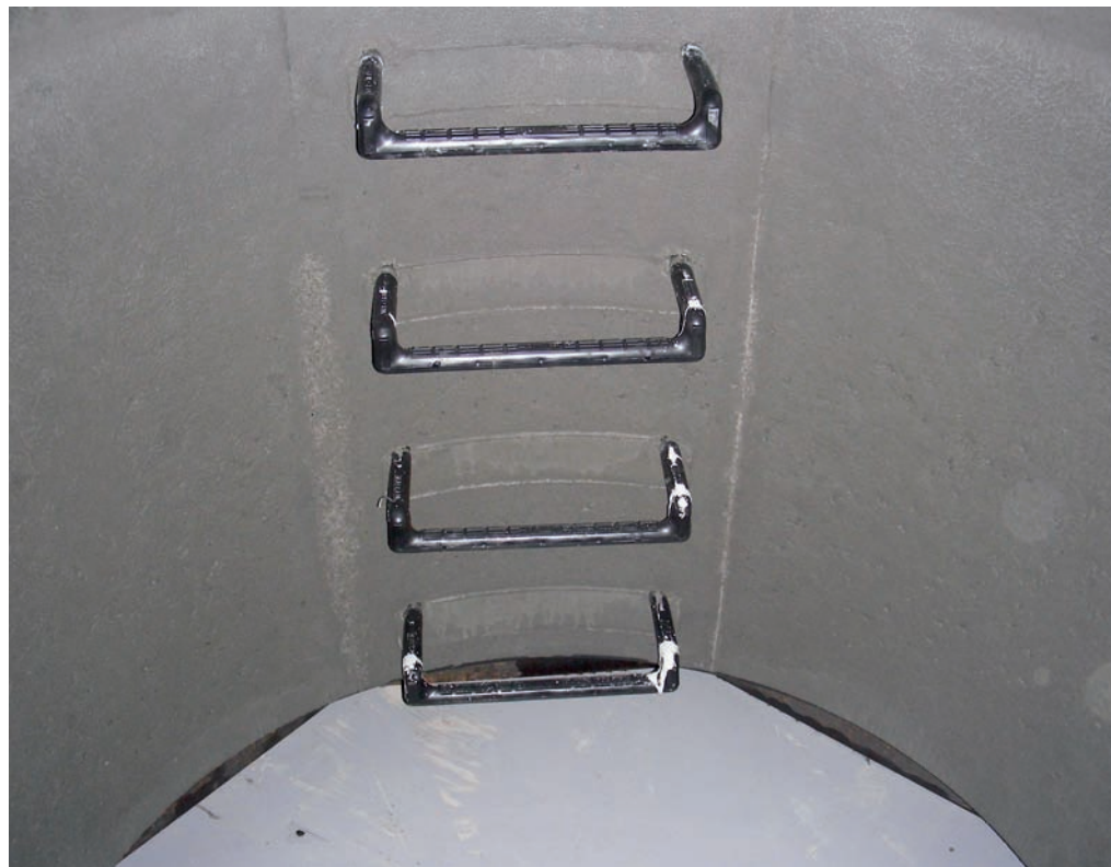
Les éléments de regard peuvent être équipés au choix d'étriers ou d'échelons.
