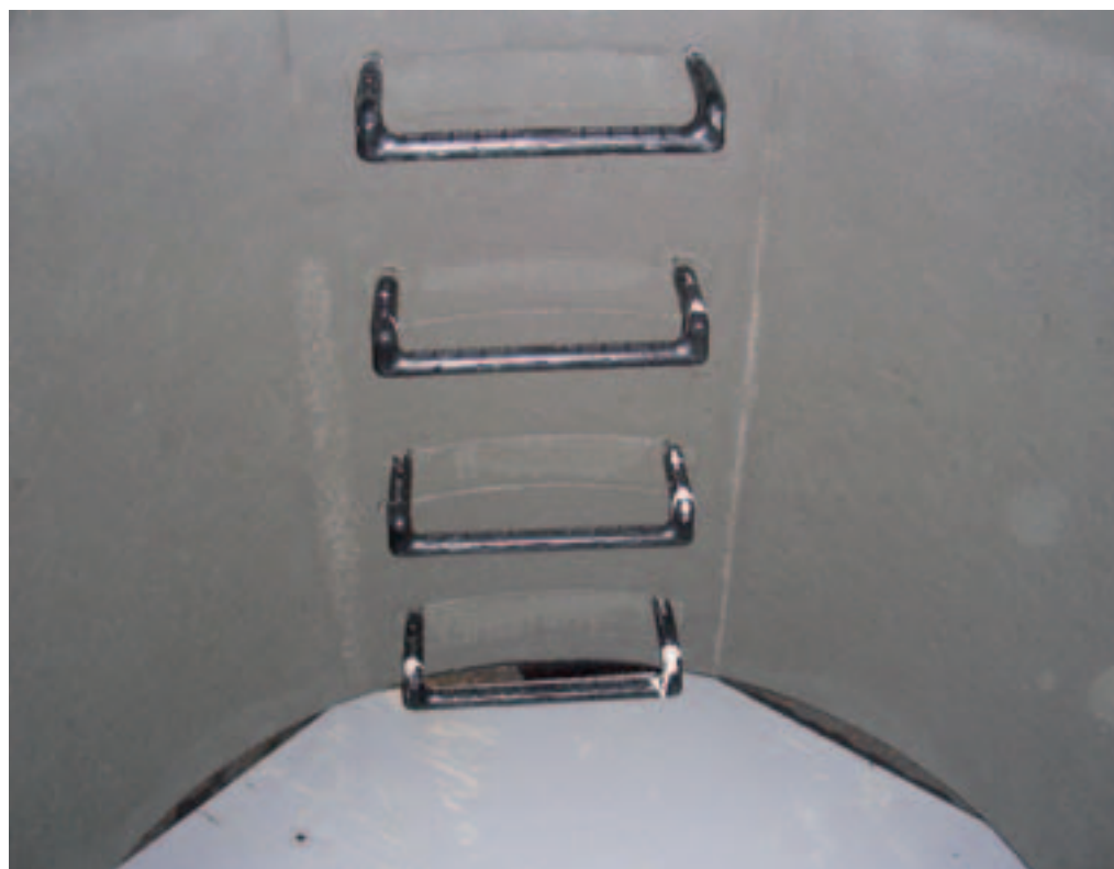
In den Schachtkomponenten kommen wahlweise Steigbügel oder Steigeisen zum Einsatz.
