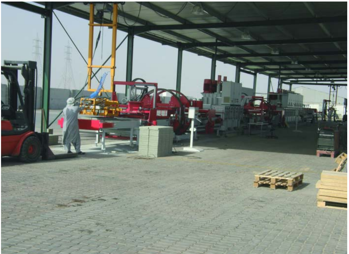
Установка начинается с ленточного конвейера, на который в полуавтоматическом режиме укладываются ряды камней
