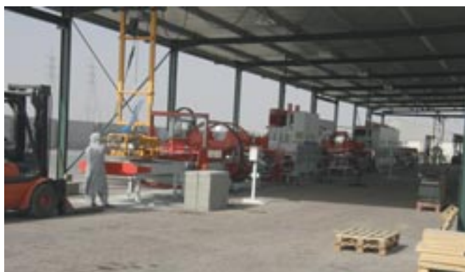
Linia do uszlachetniania zaczyna się taśmociągiem, na który w sposób półautomatyczny przekładane są warstwy kostki za pomocą chwytaka dostarczonego przez klienta.
