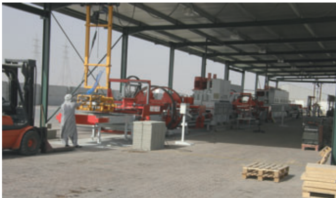
L'impianto di invecchiamento parte da un trasportatore a nastro per l'inserimento semiautomatico degli strati di manufatti mediante una staffa fornita dal cliente.
