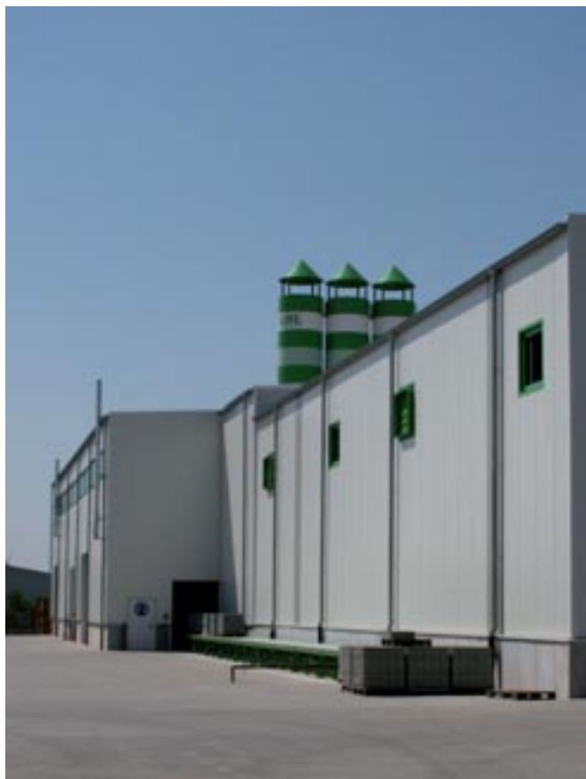
Nowy zakład betonowy EHL w Ahlhorn.
