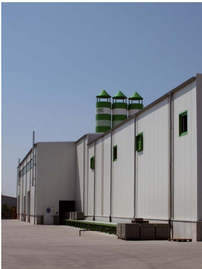
Das neue EHL-Betonwerk in Ahlhorn
