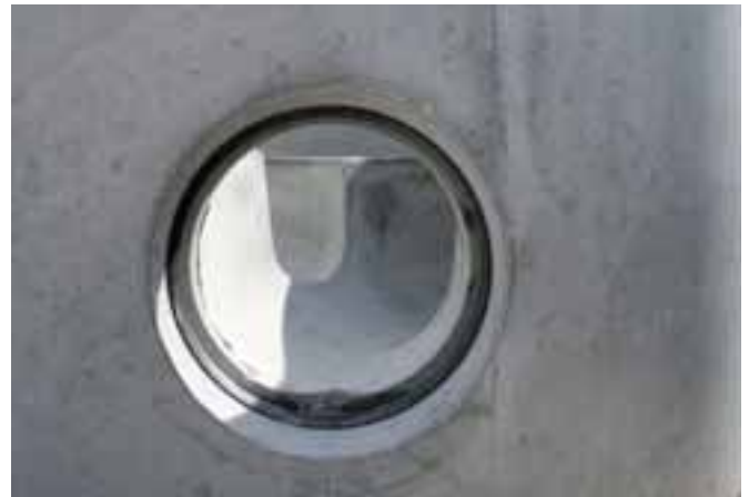
Przejście szczelne z uszczelką zintegrowaną.
