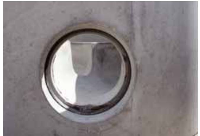
Raccordo del tubo con guarnizione integrata
