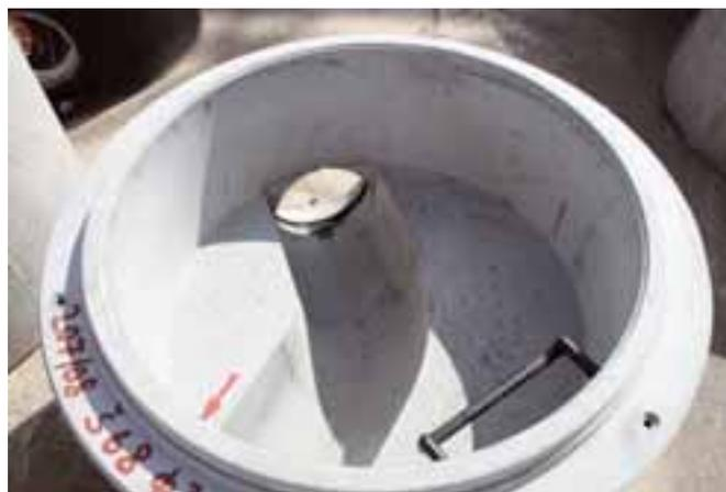
Ein Schachtunterteil für Richtungswechsel im Rohrleitungssystem
