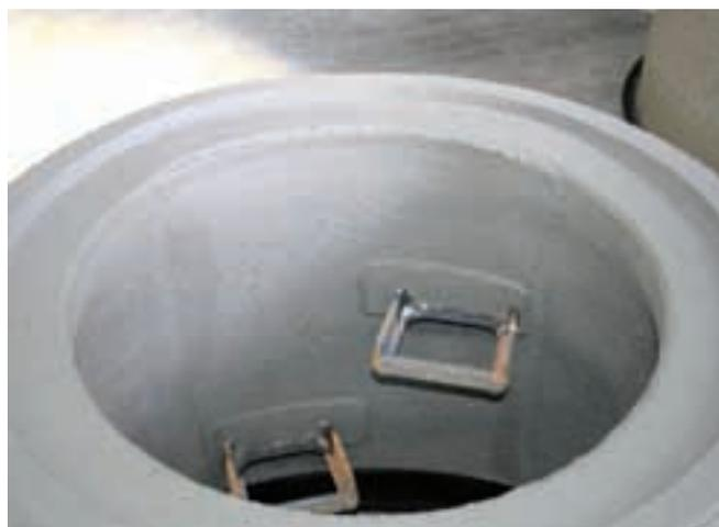
Установка скоб или подножек для подъема проходит без проблем благодаря технологии Stepmaster.
