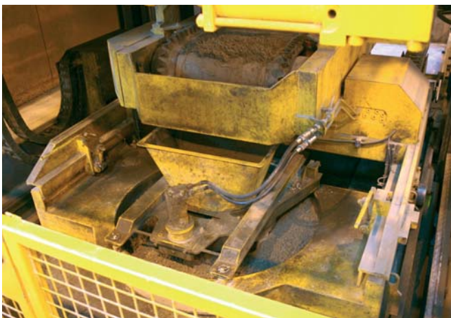
Beton dostarczany jest do maszyn produkcyjnych taśmociągłem.
