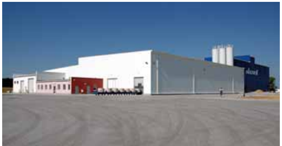
Il nuovissimo stabilimento di ZPB Kaczmarek presso Prusice – in primo piano il nastro di trasporto del sistema di fabbricazione Perfect
