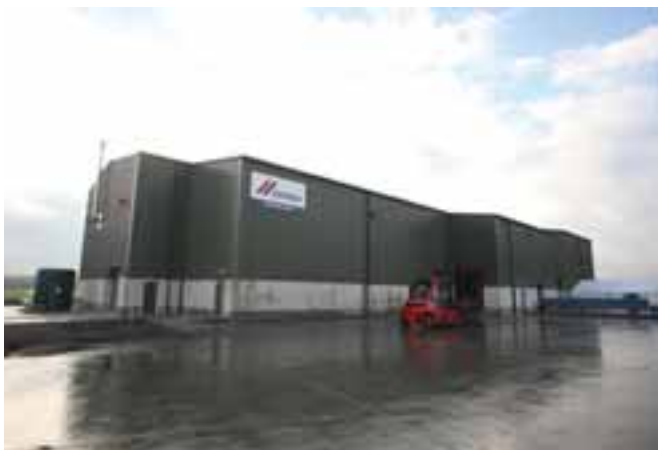
Il nuovo impianto per la produzione di blocchi in calcestruzzo in Scozia
