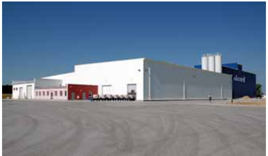
L'usine flambant neuf de ZPB Kaczmarek à Prusice – au premier plan le convoyeur de sortie du système de production Perfect
