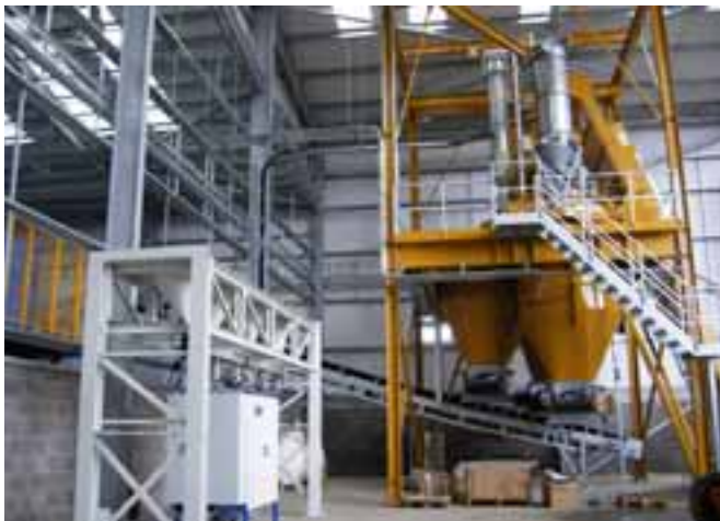
Le mélangeur de 4 500 litres de la firme Haarup produit toutes les 3 minutes 7 tonnes de matériaux. A gauche: l'installation de dosage du granulat 4 couleurs Würschum.
