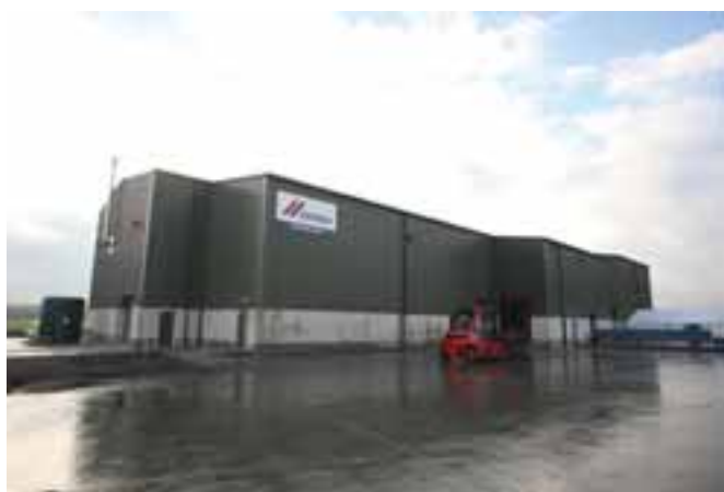
Le nouveau site de fabrication de blocs en béton en Ecosse
