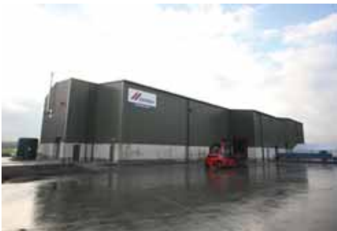
Die neue Betonsteinfertigungsanlage in Schottland
