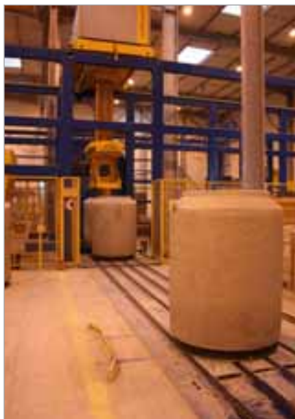
...et les rapporte ensuite à l'installation de palettisation
