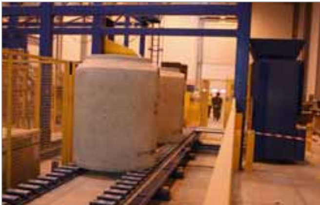
Die Schachtbauteile werden mittels Vakuum auf Dichtigkeit geprüft und markiert, bevor sie auf einem Förderband zum Außenlager transportiert werden.
