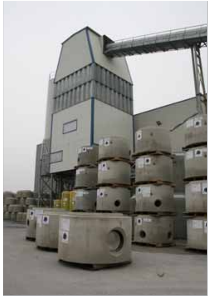
Jede Halle bei Plattard besitzt eine eigene Mischanlage für Beton, um autark arbeiten zu können.
