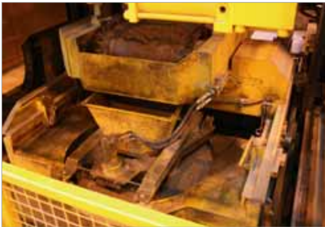
Der Beton gelangt über ein Förderband zur Produktionsanlage.
