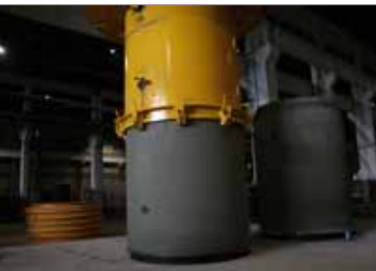
Ausfahren der gefüllten Form aus der Rohrstation und Weitertransport zum Entschalen
