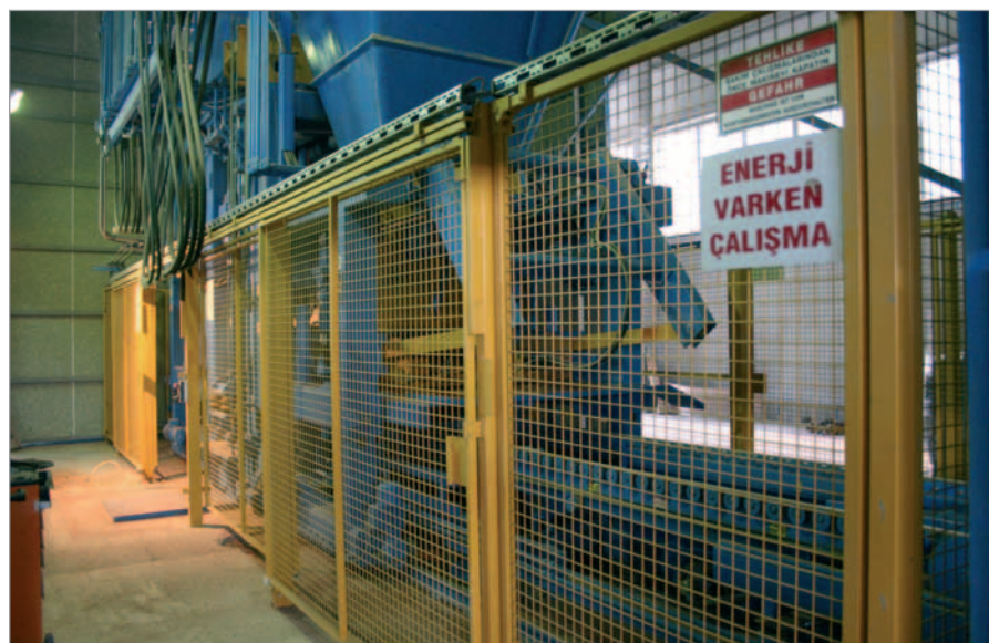
La blocciera della Özkul è recintata in conformità alle norme di sicurezza
