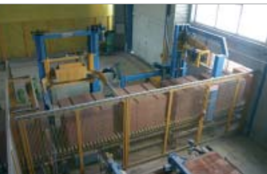
Die Umreifung der Steinpakete erfolgt mittels Umreifungsanlagen der Fa. Ridder.
