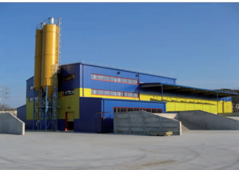
Das Werk von Musu Statyba in Kaunas, Litauen, lässt schon anhand der äußeren Farbgebung auf den Lieferanten der Maschinen und Anlagen im Inneren schließen.
