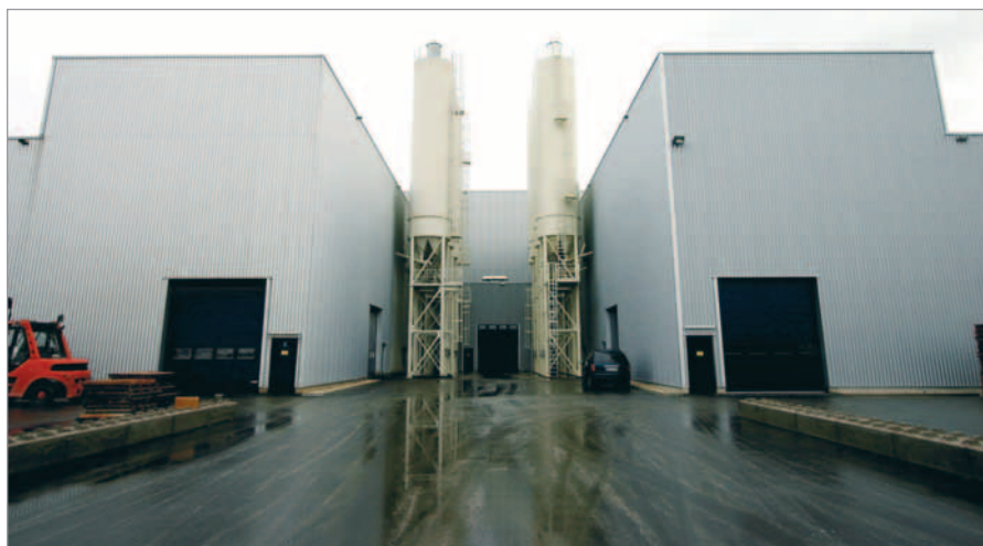
In Kevelaer wurde bei Redsun vor kurzem die zweite Masa-Anlage in Betrieb genommen
