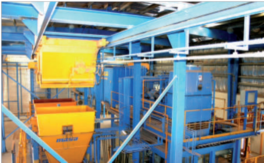
Blocchiera e carro ponte con vagonetti aerei in Bucomac, sullo sfondo si può osservare la "Cooling Tower" sulla piattaforma idraulica
