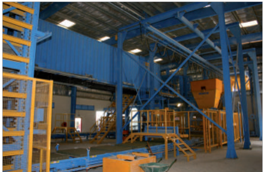
Trasporto dei prodotti sul lato bagnato e container degli armadi elettrici
