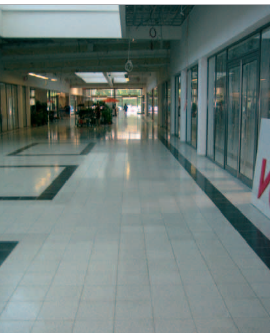
En combinaison avec le nouveau matériau de joint, aucuns problèmes d'hygiène n'apparaissent pour les sols en pierre de béton.
