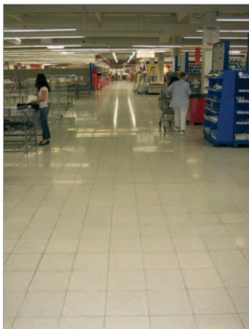
La protection de surface offre une résistance élevée à l'usure pour les sols en pierre de béton.
